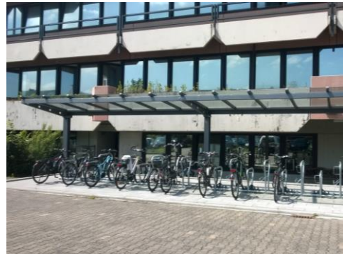
Abstellanlagen für Mitarbeiter auf der Rückseite des Rathauses
