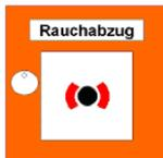
Das Bedientableau für die Entrauchungsanlagen ersetzt nicht die nach Baurecht oder Brandschutzkonzept erforderlichen Handsteuereinrichtungen (Handtaster).
