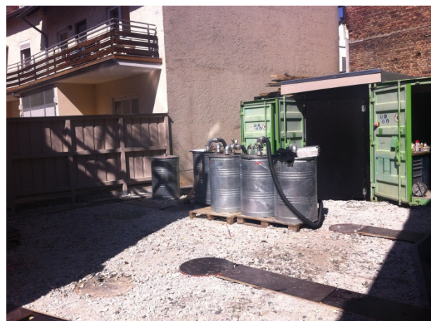
Abbildung 4: Brunnenkopf (I), Zustand Sanierungsfläche mit den unterflur verlegten Leitungen, neuem Sichtschutzzaun und Schallschutzmaßnahmen / Containern
