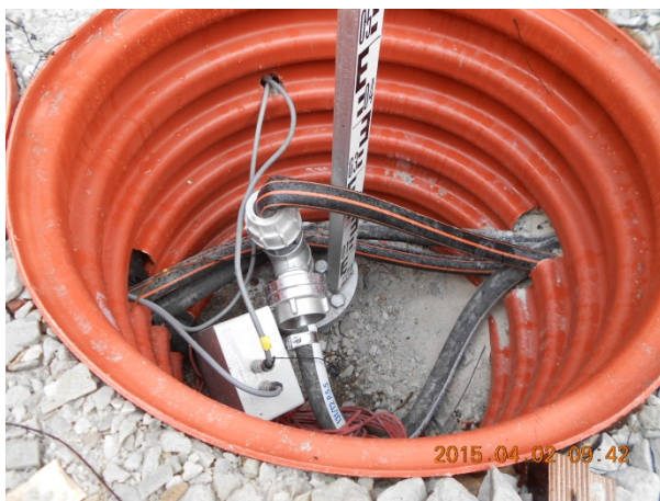
Abbildung 4: Brunnenkopf (I), Zustand Sanierungsfläche mit den unterflur verlegten Leitungen, neuem Sichtschutzzaun und Schallschutzmaßnahmen / Containern
