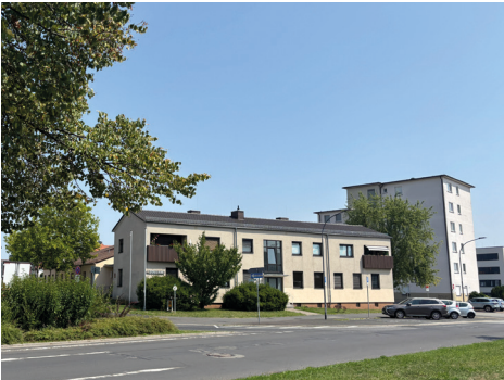
Abb. 28: Gebäude des Zollamtes
