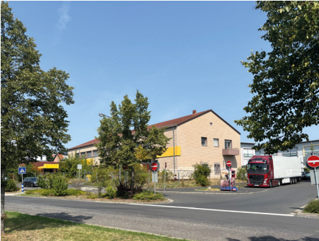
Abb. 27: leerstehendes, ehemaliges Postgebäude
