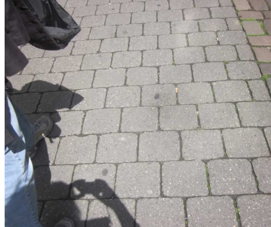
Abb. 8-19: Stolperfreier Wegebelag durch Verfugen
