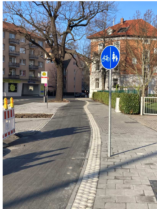
Abb. 8-14: Taktile Leitstreifen zwischen Rad- und Gehweg (Braunschweig)
