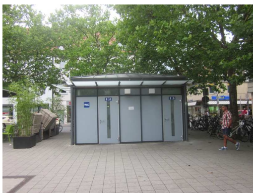
Abb. 8-47: Barrierefreie Öffentliche Toilettenanlage (Erlangen)
