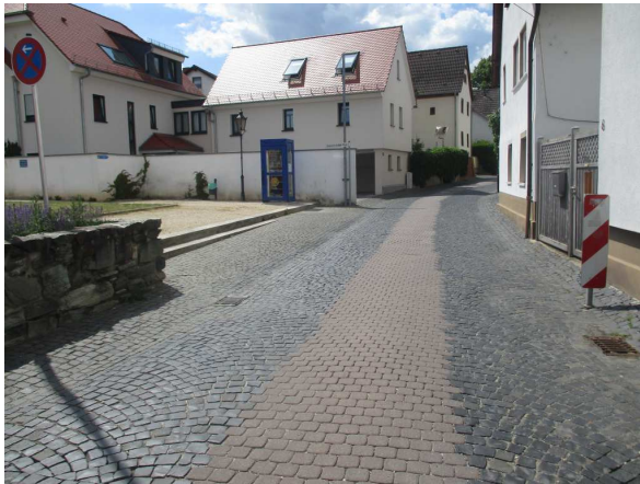
Abb. 8-18: Ortsmitte Stierstadt: mittiger-barrierefreier Pflasterstreifen
