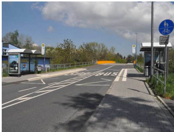
Abb. 7-20: Im Heidegraben (Brücke Fichte- straße)
