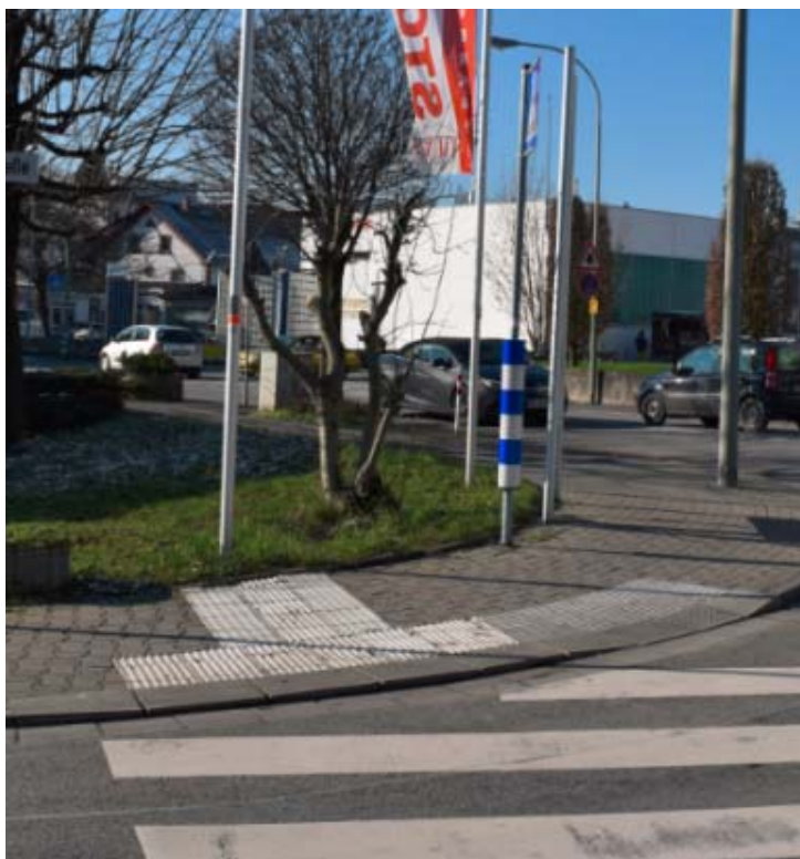
Abbildung 21 Bordsteinabsenkungen und Blindenleitsystem an vielen Querungen vorhanden, Quelle: eigene Aufnahme 2018
