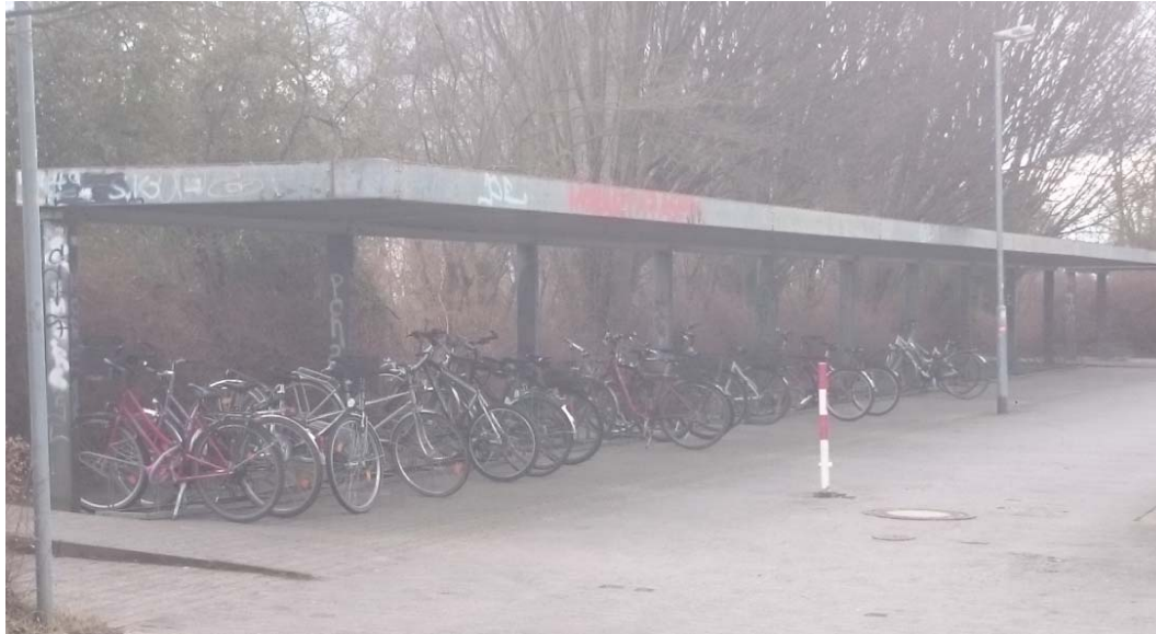
Abbildung 26 Radabstellanlagen an der S-Bahnstation Weißkirchen/Steinbach, Quelle: eigene Aufnahme
