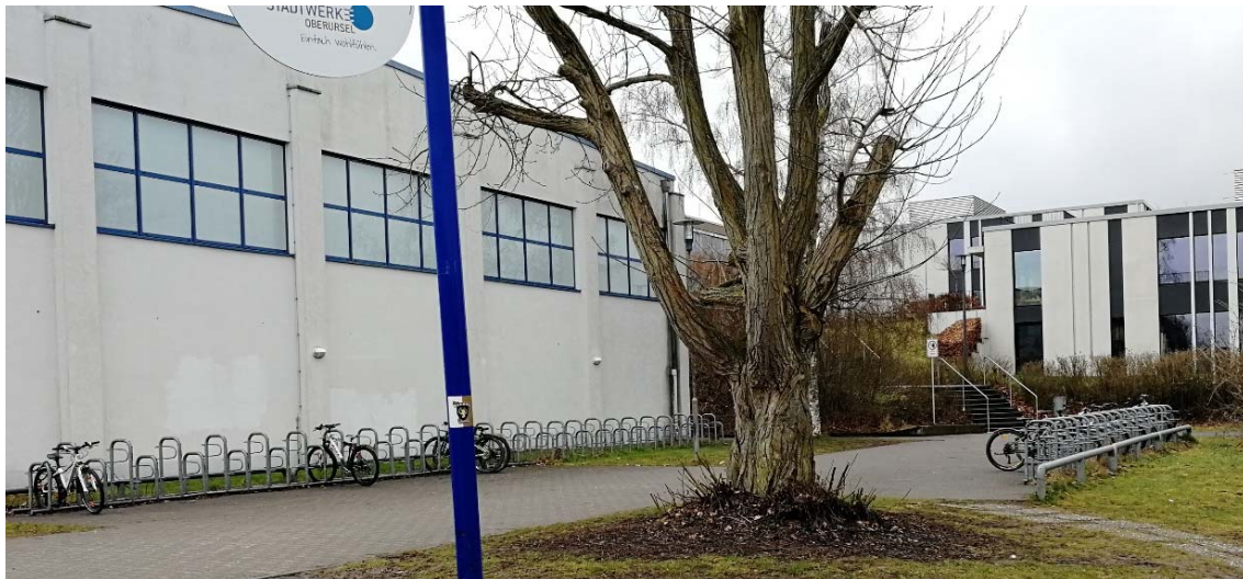
Abbildung 29 Radabstellanlagen an der IGS-Stierstadt, Quelle: eigene Aufnahme 2018
