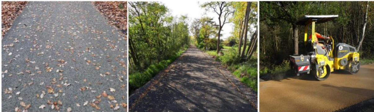
Abbildung 6: Asphaltähnliche Deckschichten aus Gemisch von Basaltstein und Spezialsand / heller Split-Mastix-Asphalt, (Quelle: Planungsbüro RV-K)
