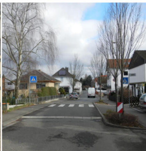
Beispiel 2: Aufpflasterung und Einengung
