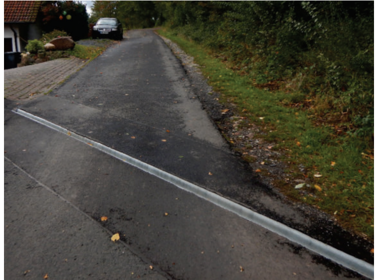
Entwässerungsrinne auf Wirtschaftsweg
