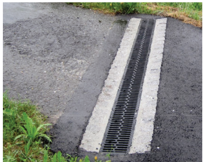
Entwässerungsrinne mit befahrbarem Gitter
