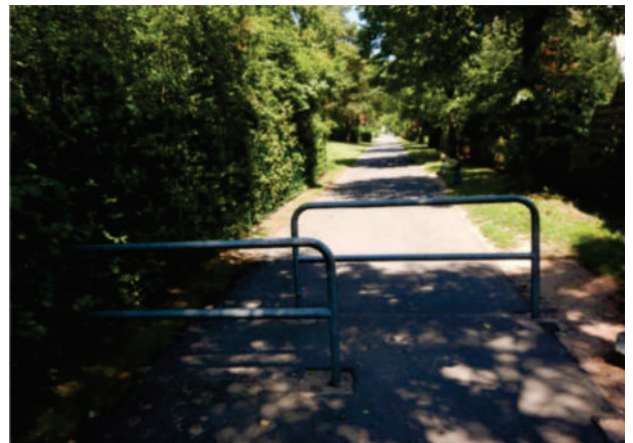
Abbildung 1: Umlaufsperrern mit zu geringer Durchgangsbreite Überlappung der Gitter und ohne (reflektierende) Markierung
