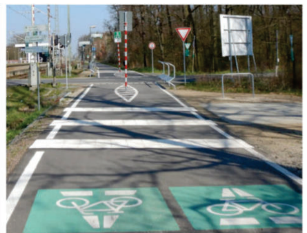
Abbildung 3: Baulicher "Rüttelstreifen" mit taktilen Elementen (Rippenplatten) zur Aufmerksamkeitssteigerung
