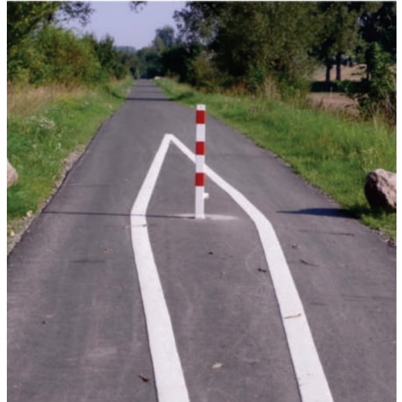
Abbildung 1: Warnmarkierung eines Sperrpfostens
