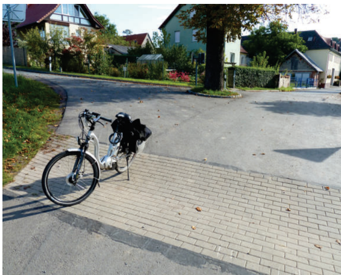
Großzügige Mulde als Entwässerungsrinne
