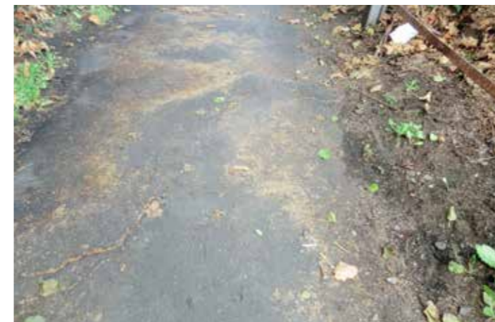
Wurzelhub (Bild: R+T)
