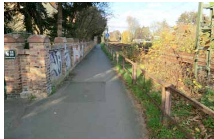
Blick von Süden auf Beginn der Engstelle (Bild: R+T)
