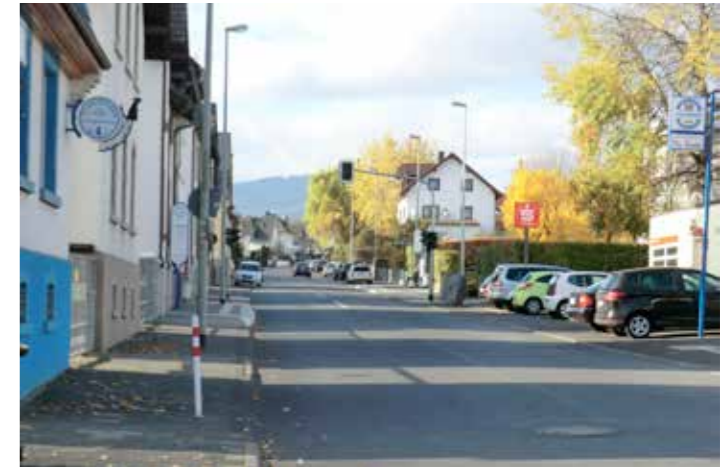
Blick von Knotenpunkt auf FSA (Bild: R+T)
