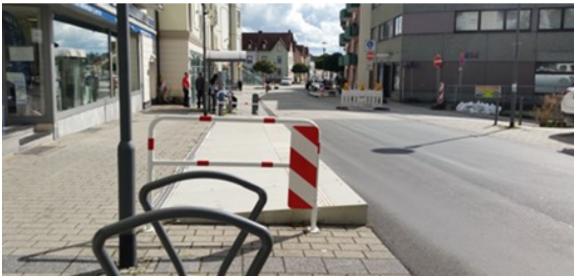
Abbildung 31: Diese Bushaltestelle wurde mit Hilfe von aufschraubbaren Fertigelementen barrierefrei umgestaltet, so dass keine aufwändigen Tiefbauarbeiten nötig waren eigene Aufnahme 2023
