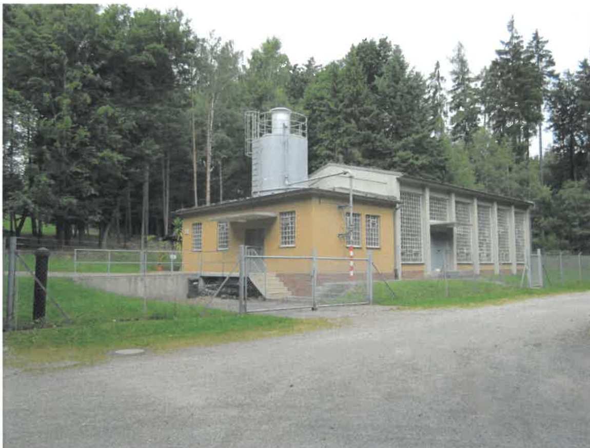
Abb. 4: Trinkwasseraufbereitungsanlage ESA Hohemark
