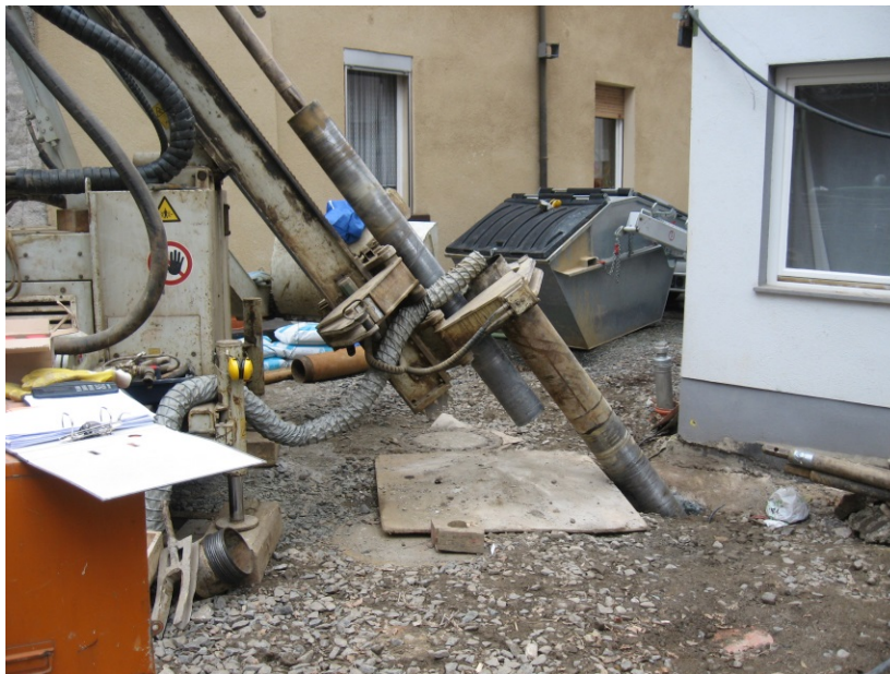
Abbildung 2: Bohrgerät mit Lutte (flexible Schlauchleitung)
