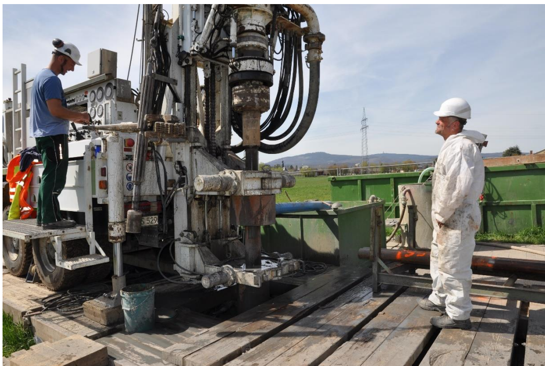
Abb. 10: Bohrung im Bommersheimer Feld für Versuchsbrunnen
